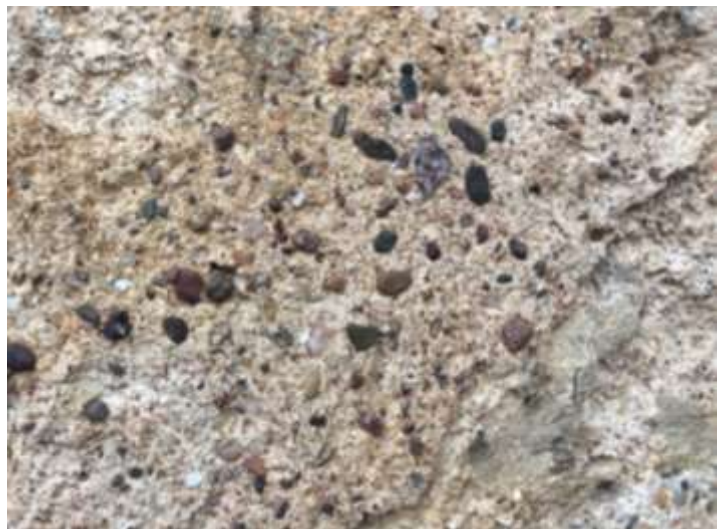
Enduits à la chaux avec sables de rivière et de carrière bien visibles (Maisons Loigerot à Frasne et Batit à Bucey les Gy)
