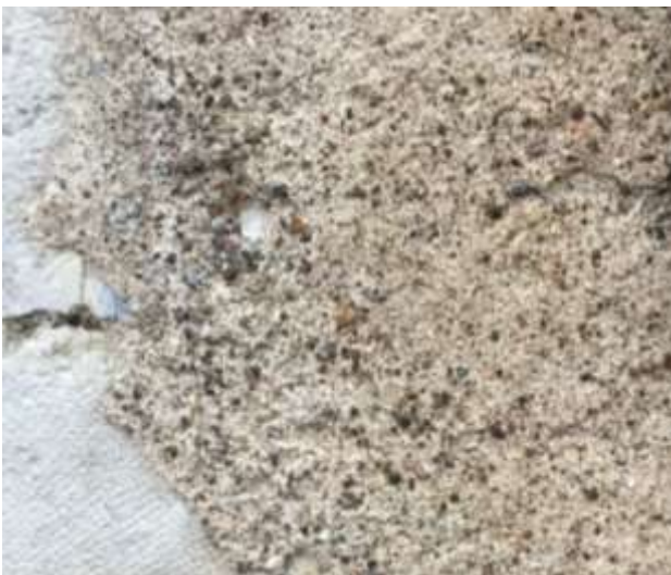
Enduits à la chaux avec sables de rivière et de carrière bien visibles (Maisons Loigerot à Frasne et Batit à Bucey les Gy)
